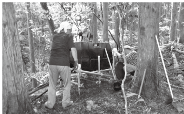
（7月20日給水タンクの清掃をしました）
